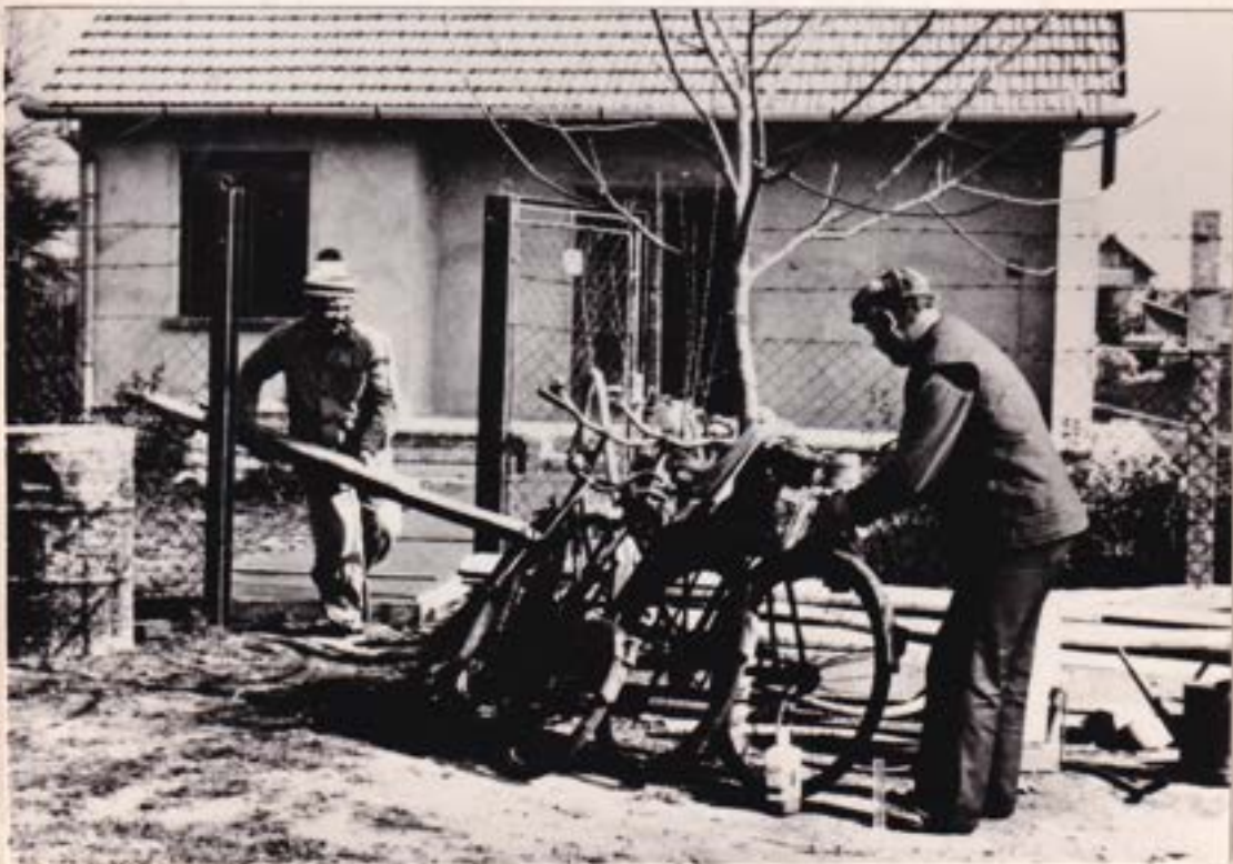
A nyaraló építése közben
